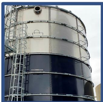
Se aplica una junta de masilla para garantizar la hermeticidad entre las láminas. Nuestras masillas cumplen la norma ISO 9047 relativa a las propiedades de adhesión/cohesión de las masillas a temperaturas variables.
